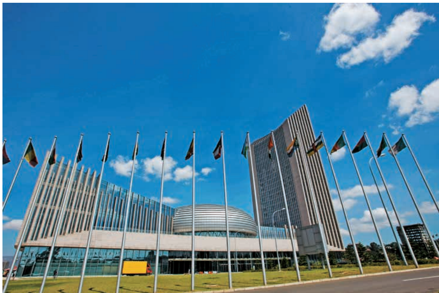
非盟总部大楼
